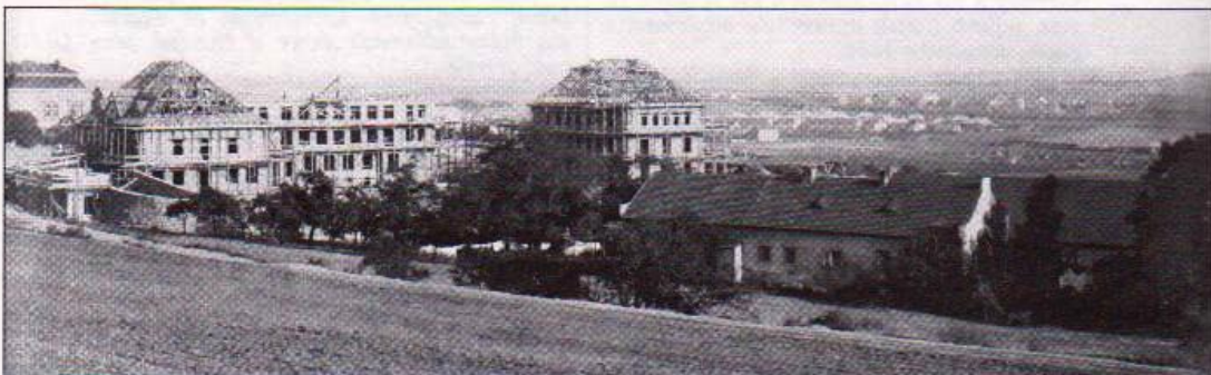
Rozestavěné budovy č. 1, 2 a 3. Na místě dnešní budovy č. 11 stál statek.
