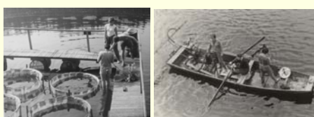
Vlevo: Pokusné terénní nádrže na testování algičidů na Sedlici. Vpravo: Aplikace modré skalice na nádrži Sedlice. Rok 1959.
