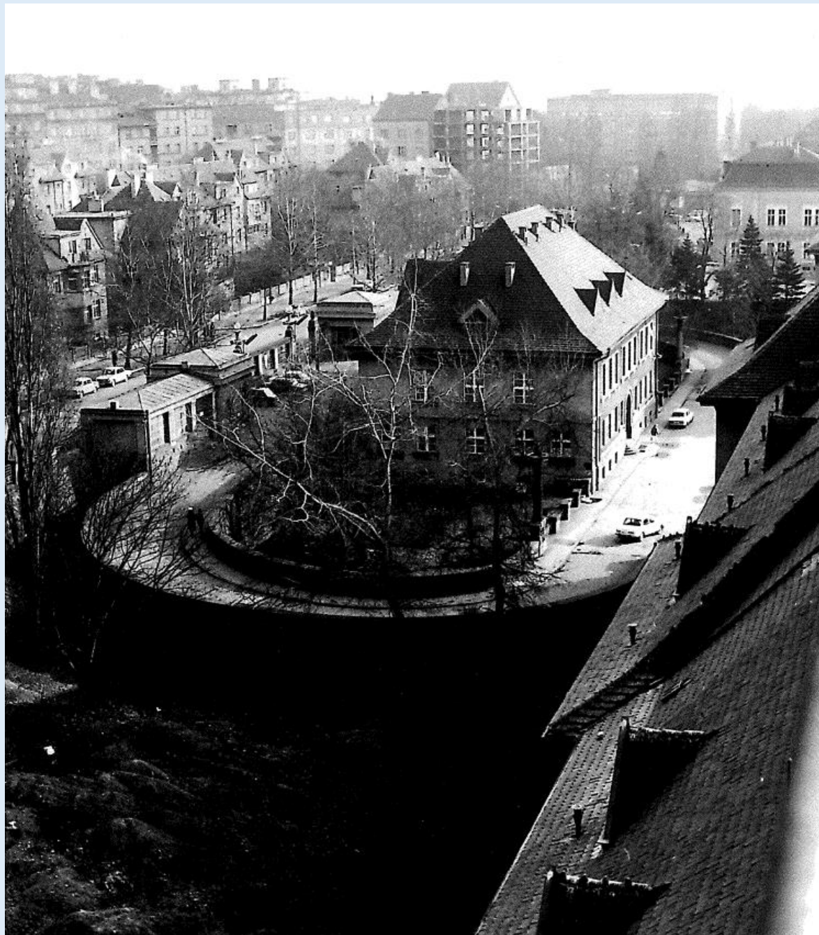
Pohled na hlavní vchod ve Šrobárově ulici a budovu ředitelství, SZÚ
